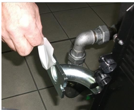
7) Снять заглушку из Труба ГАЗОВОЙ ramпы;
