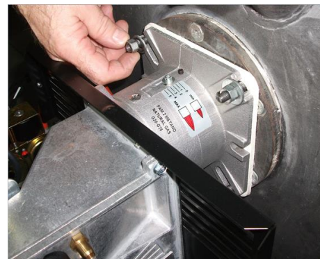
6) Зафиксировать горелки на котел;
