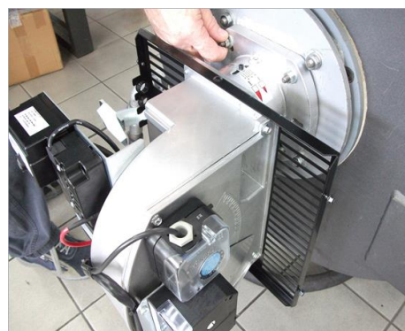
6) Зафиксировать горелки на котел;
