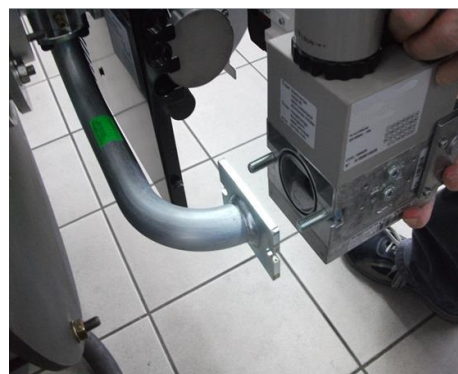
9) установить электроклапан на Труба ГАЗОВОЙ ramпы;
